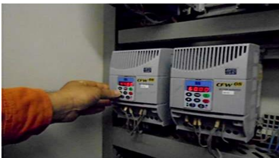
FIGURA 8 – Alterações dos parâmetros dos inversores
